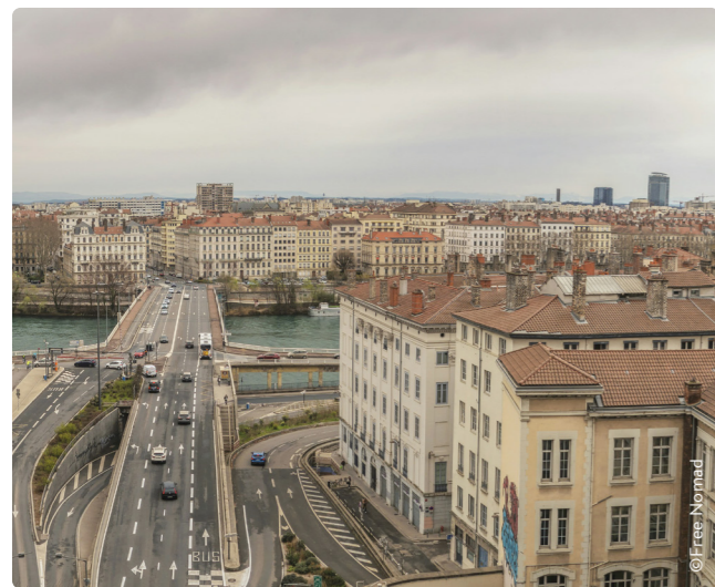
Vue de Lyon, sortie du tunnel de la Croix-Rousses.
